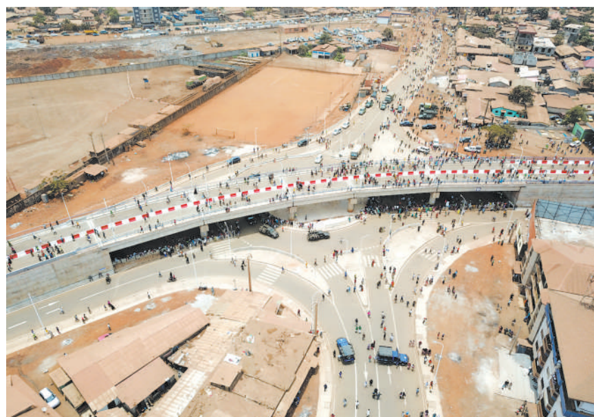
4月18日，由中国企业承建的几内亚科纳克里卡格贝立立交桥竣工通车。新华社发
