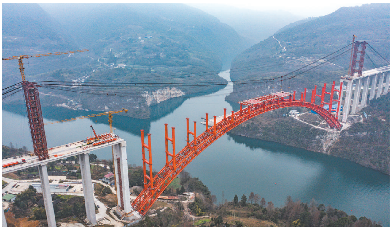
近日，德(江)余(庆)高速乌江特大桥施工进度顺利，大桥建设进入桥面系施工阶段。图为正在进行桥面系施工的德余高速乌江特大桥(无人机照片)。
