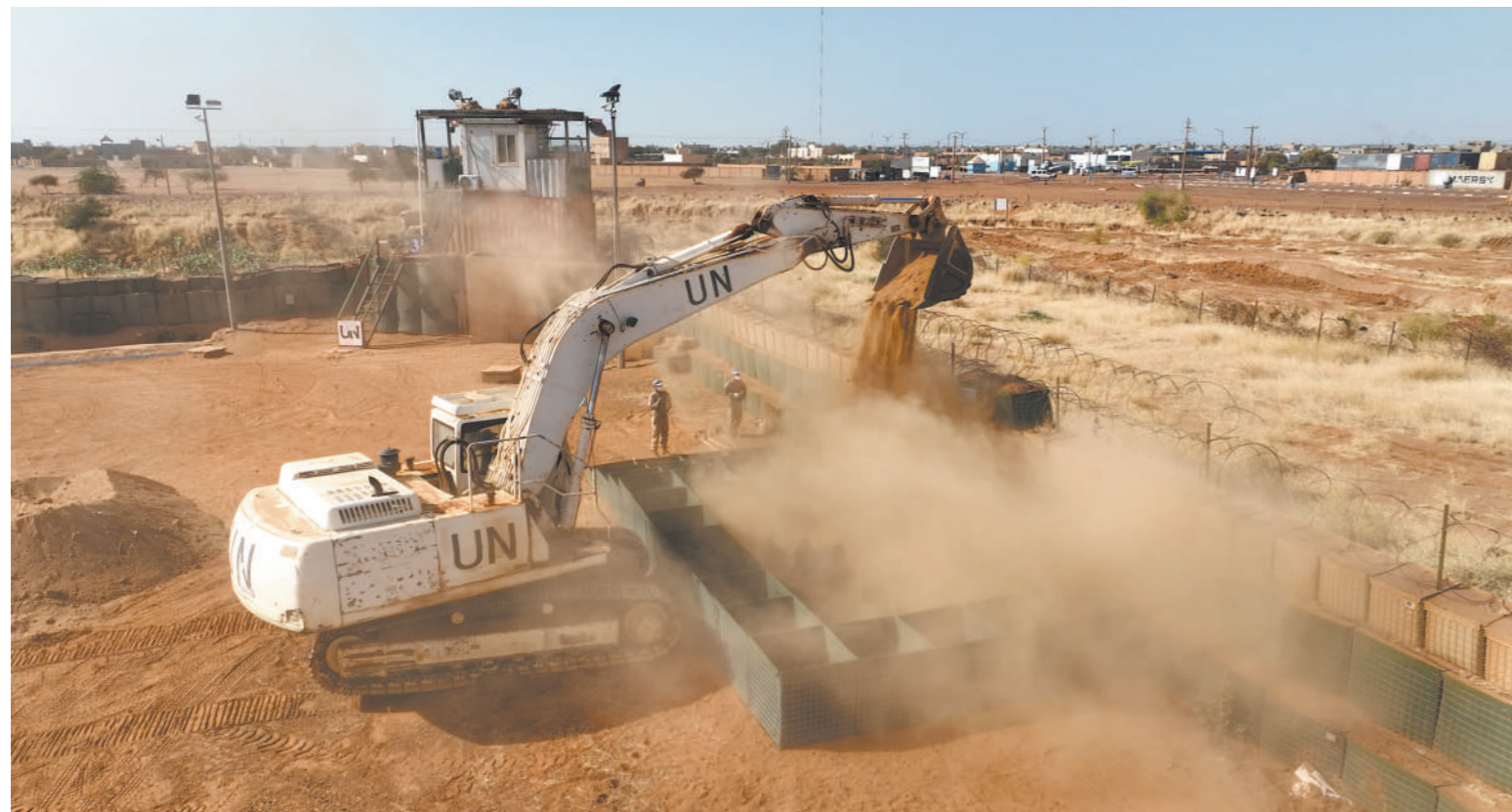
2月11日,经过连续两天紧张作业,中国第10批赴马里维和工兵分队完成联马团加奥超级营地防御工事紧急修复任务,进一步提升了该营地的整体安防水平。图为我维和官兵在施工期间进行防御沙箱装填作业。葛学禹摄
