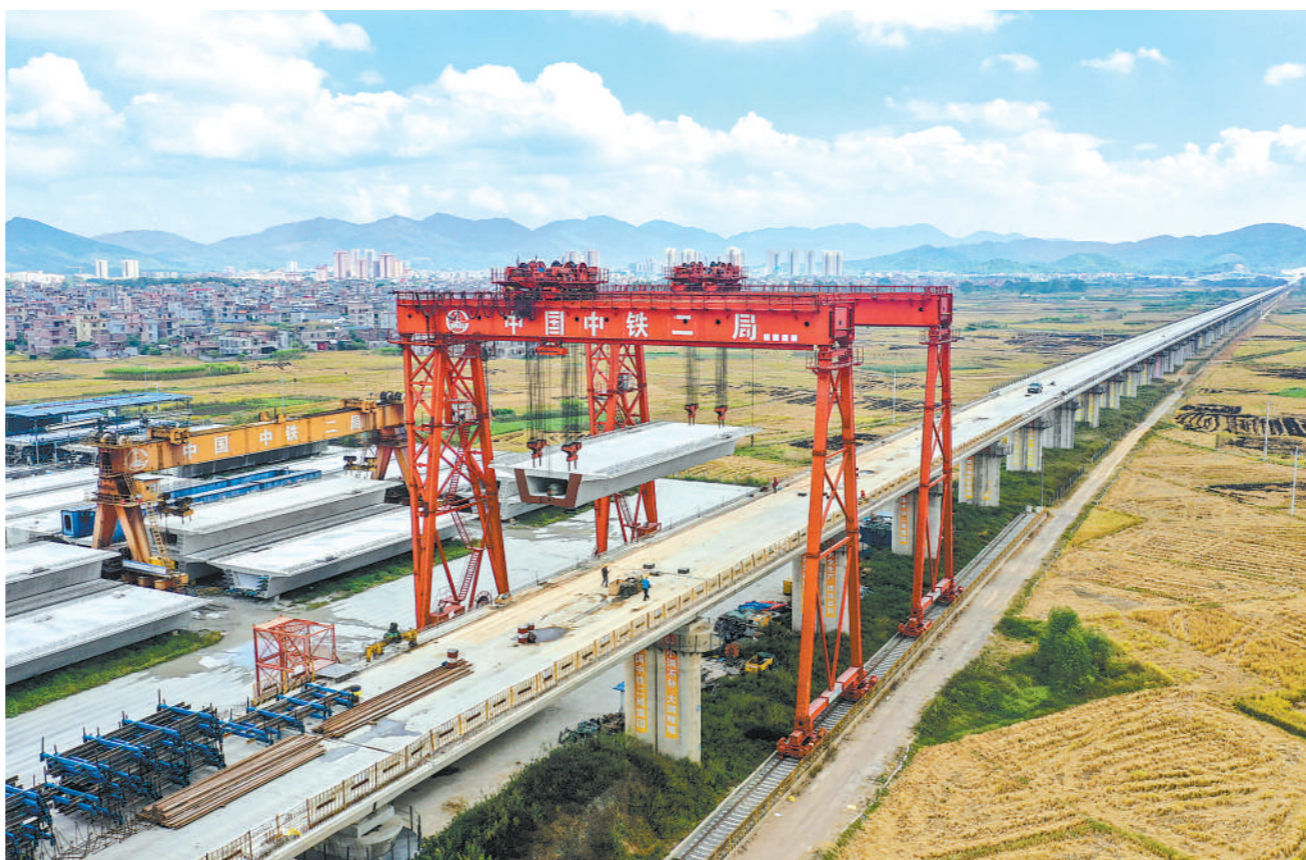
11月10日,南玉铁路站前工程7标段附近一处制梁场在进行箱梁吊装作业。南玉铁路是南宁至深圳高铁的重要组成部分,设计时速350公里。 新华社记者 曹祎铭摄
