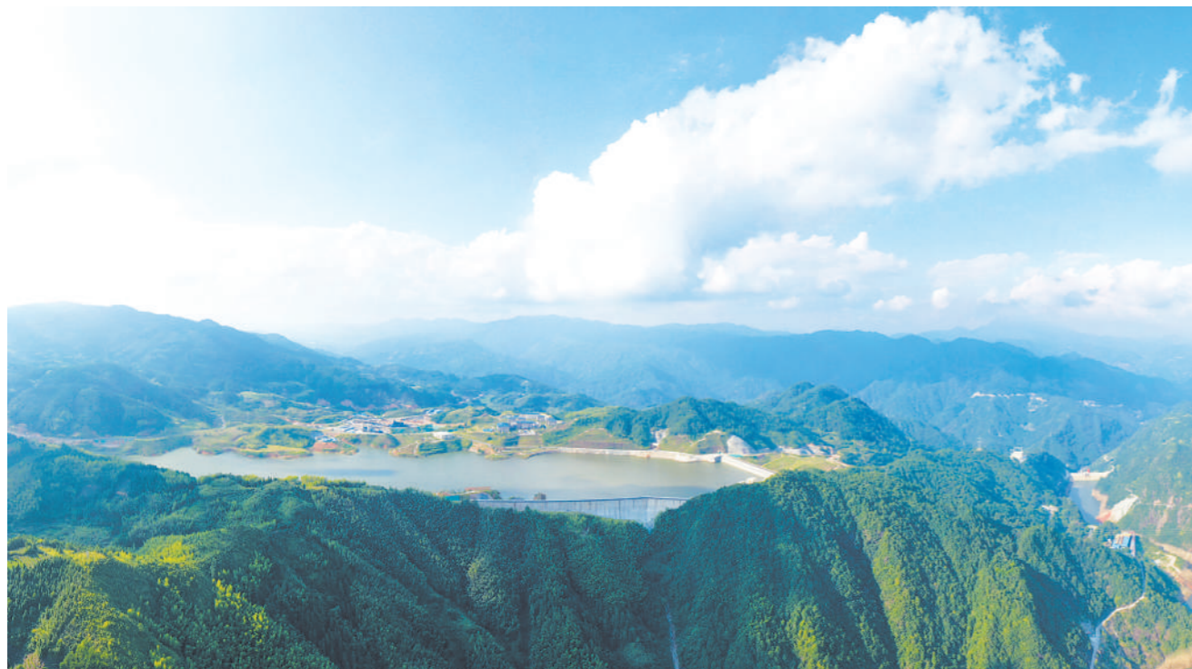
8月28日，中国华电福建周宁抽水蓄能电站4号机组正式投入运行，标志着中国华电首座、“十四五”期间福建省首个抽水蓄能电站全容量投产发电。该电站为日调节纯抽水蓄能电站，总装机容量120万千瓦，年发电量12亿千瓦时。图为当日拍摄的福建周宁抽水蓄能电站。
