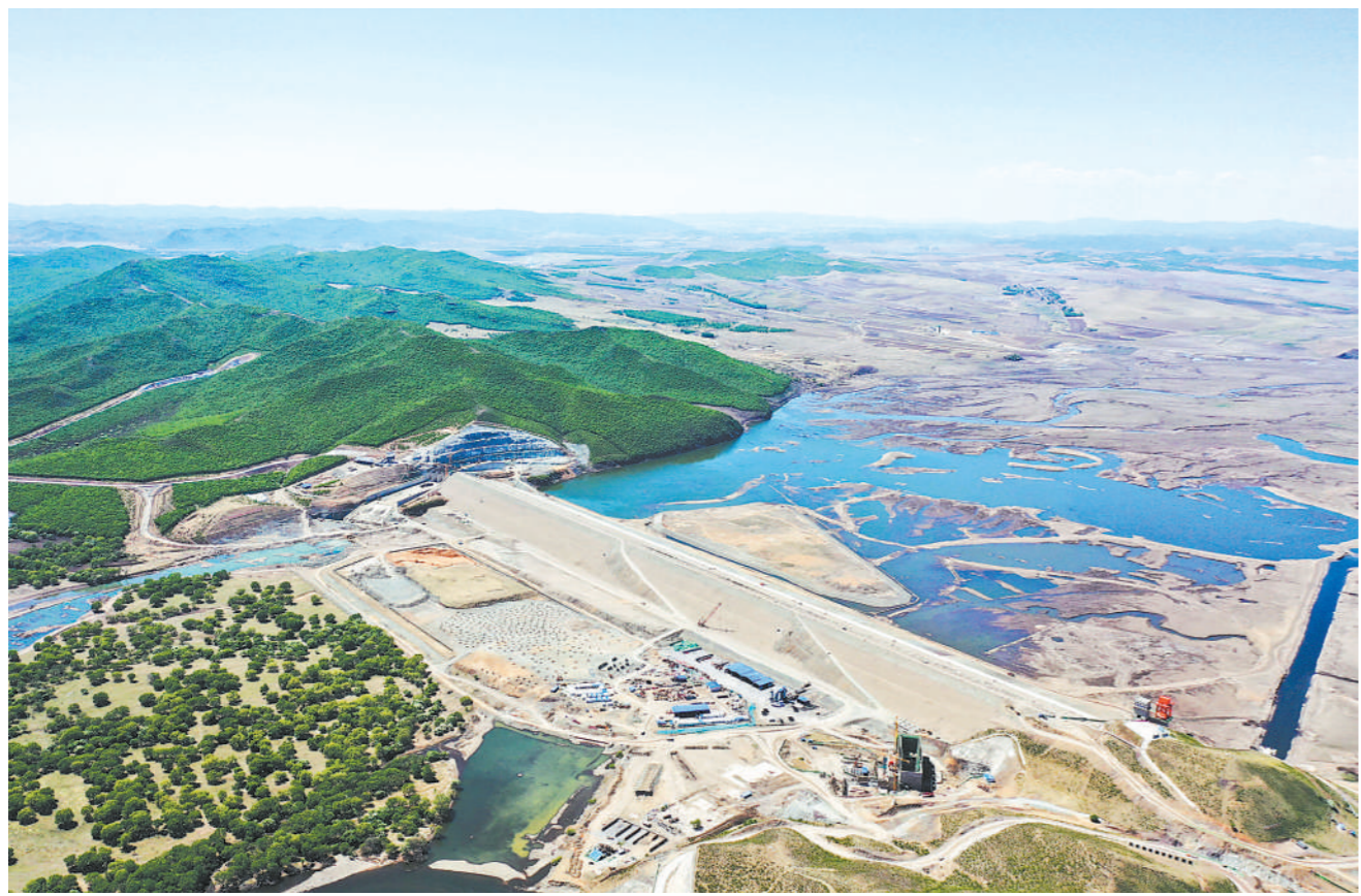
近日，内蒙古自治区引绰济辽工程有序推进，工人们在现场加紧施工。引绰济辽工程输水线路全长390.3公里，设计年平均调水量4.54亿立方米，可以有效缓解内蒙古自治区东部西辽河流域严重缺水状况。这是5月21日拍摄的引绰济辽工程文得根水利枢纽施工现场（无人机照片）。新华社记者 刘磊摄
