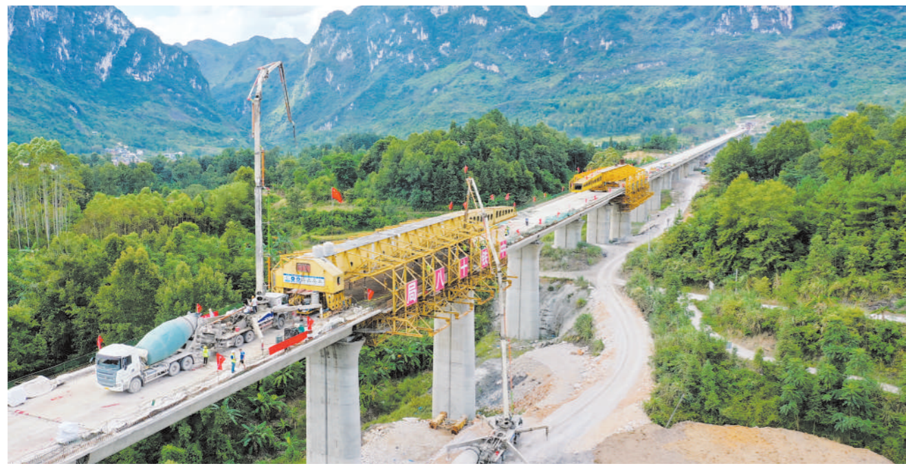
这是正在进行最后混凝土浇筑的捞村双线特大桥(无人机照片,9月16日摄)。当日,由中铁十八局集团承建的贵南高铁捞村双线特大桥顺利合龙。捞村双线特大桥位于贵州省荔波县境内,全长约2138米,最高墩达49米。
