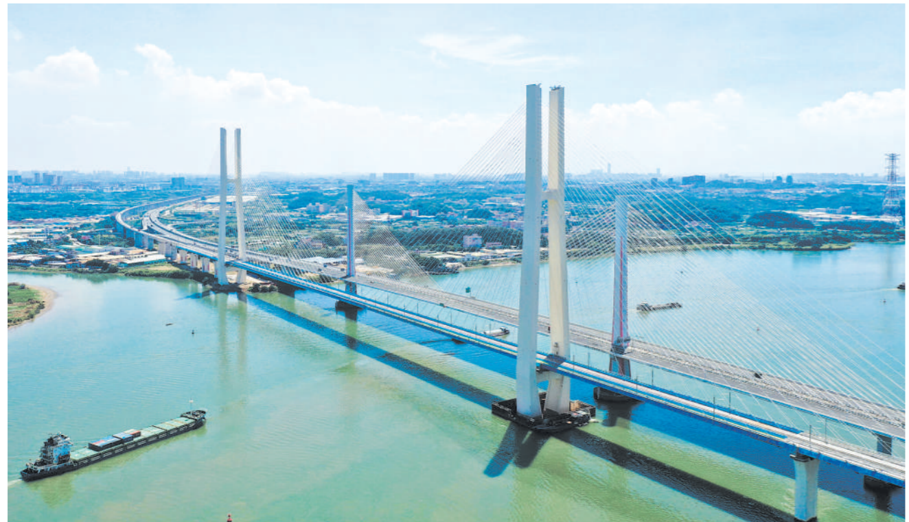
9月15日拍摄的完成左线铺轨的广州南沙铁路跨西江特大斜拉桥(无人机照片)。近日，由中铁十一局承建的粤港澳大湾区基础设施“硬联通”重点工程——广州南沙铁路跨西江特大斜拉桥完成桥面左线铺轨施工，为工程如期建成开通奠定基础。该桥位于广东佛山市和江门市交界处，全长1117.5米。 新华社发
