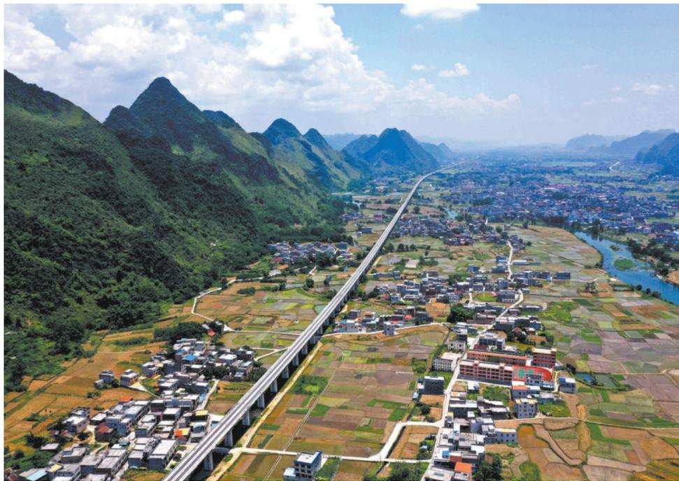
7 月 26 日拍摄的贵南高铁澄江双线特大桥。当日,贵南高铁澄江双线特大桥最后一榀箱梁架设完毕,标志着贵南高铁全线第一长桥澄江双线特大桥顺利竣工。贵南高铁贯穿广西北部 and 贵州东南部,是广西首条设计时速 350 公里的高速铁路。 新华社发
