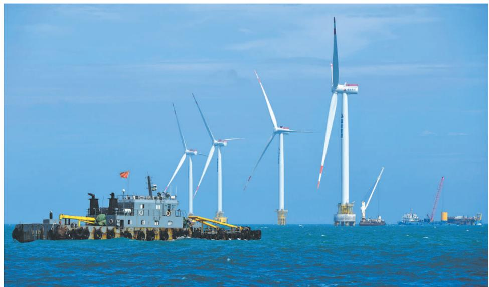
5月21日，一根直径6.7米的嵌岩单桩在福建省莆田南日岛西南侧海域成功植入海底。至此，由福能集团三川海上风电有限公司开发建设，中交一航局负责施工的29台单机容量7兆瓦风机（含6台嵌岩单桩基础型式、23台高桩承台基础型式）桩基全部完成，取得工程重要节点突破。图为莆田平海湾海上风电场项目施工现场（5月21日摄）。新华社发
