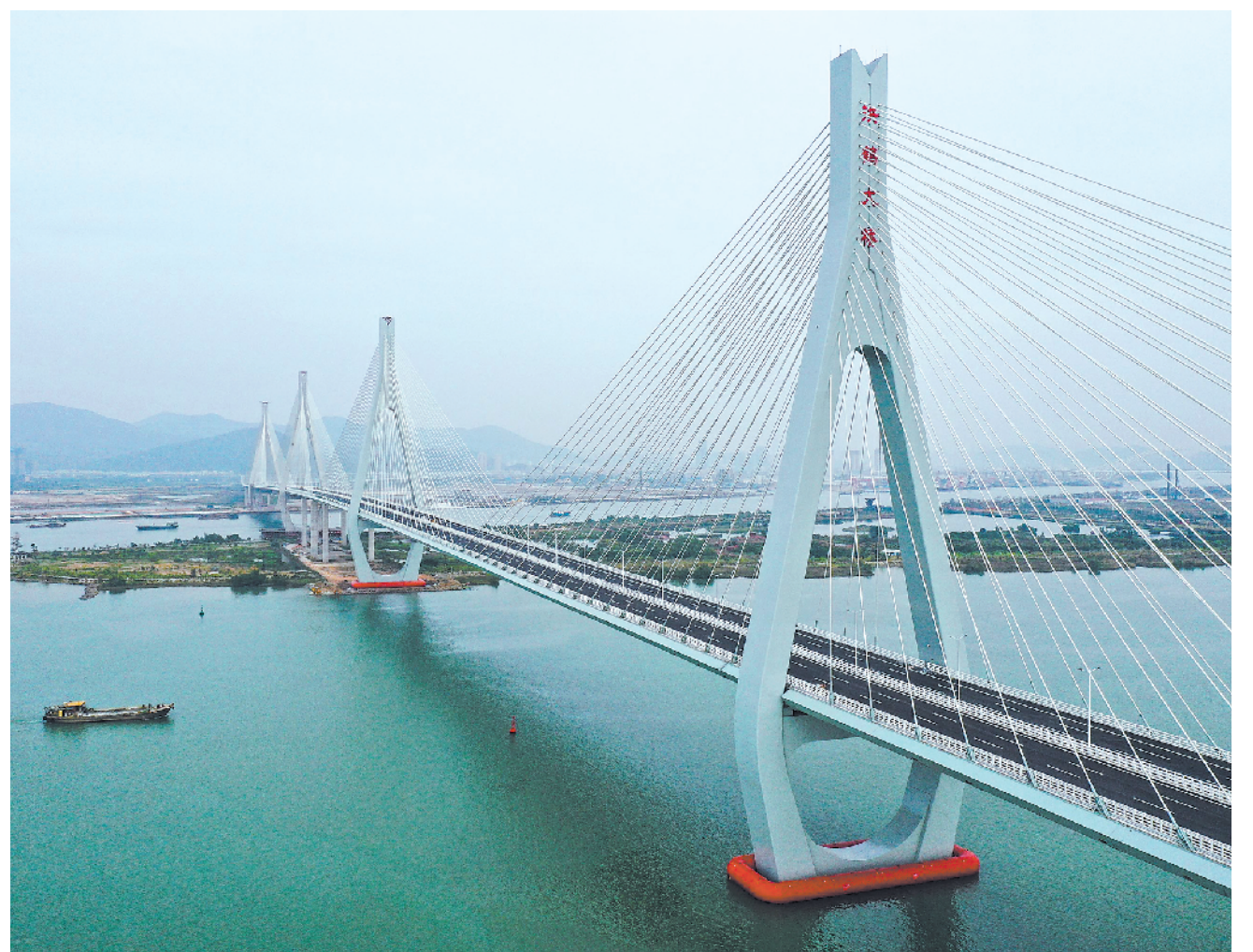
珠海鹤洲高速公路全长35公里,东起珠海澳大桥连接线,西至珠海鹤洲岛,远期对接江门黄茅海。项目建成后将成为珠江口西岸地区快速对接粤港澳大湾区的主通道。图为位于珠江口磨刀门水道的鹤洲高速洪鹤大桥。 新华社发
