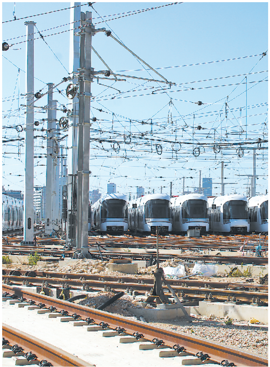
由中资企业承建的特拉维夫红线轻轨项目是以色列特拉维夫市轨道交通规划中第一条轻轨线路。新冠疫情暴发后，来自中国的建设者们坚守于此，确保施工生产稳步推进。根据中以双方的合作协议，这条轻轨铁路计划明年年底正式开通运营，目前正处于冲刺阶段。图为停在该项目车辆段现场的列车。
