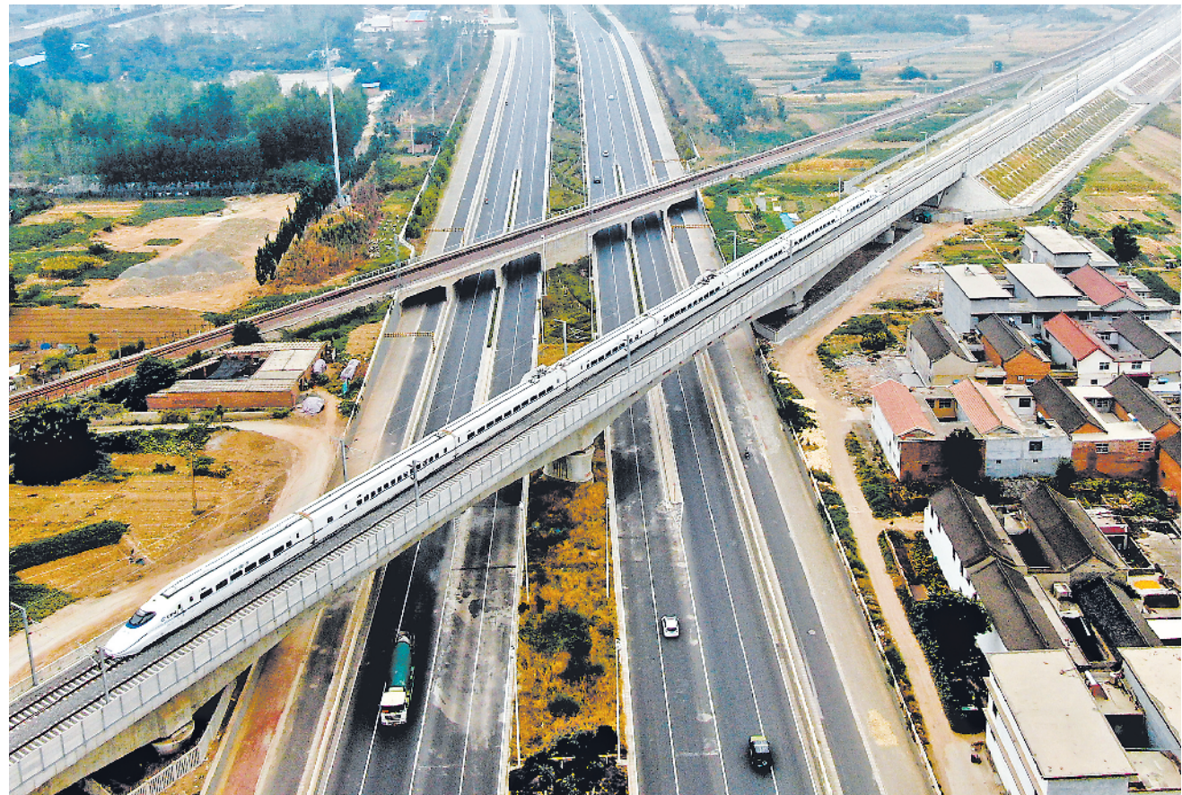
9月26日,随着D55602次综合检测列车从焦作站驶出,新建大(原)焦(作)铁路郑州局管段正式开始联调联试动态检测,标志着该铁路进入开通运营倒计时。图为D55602次综合检测列车行驶在焦作站附近的线路上。
