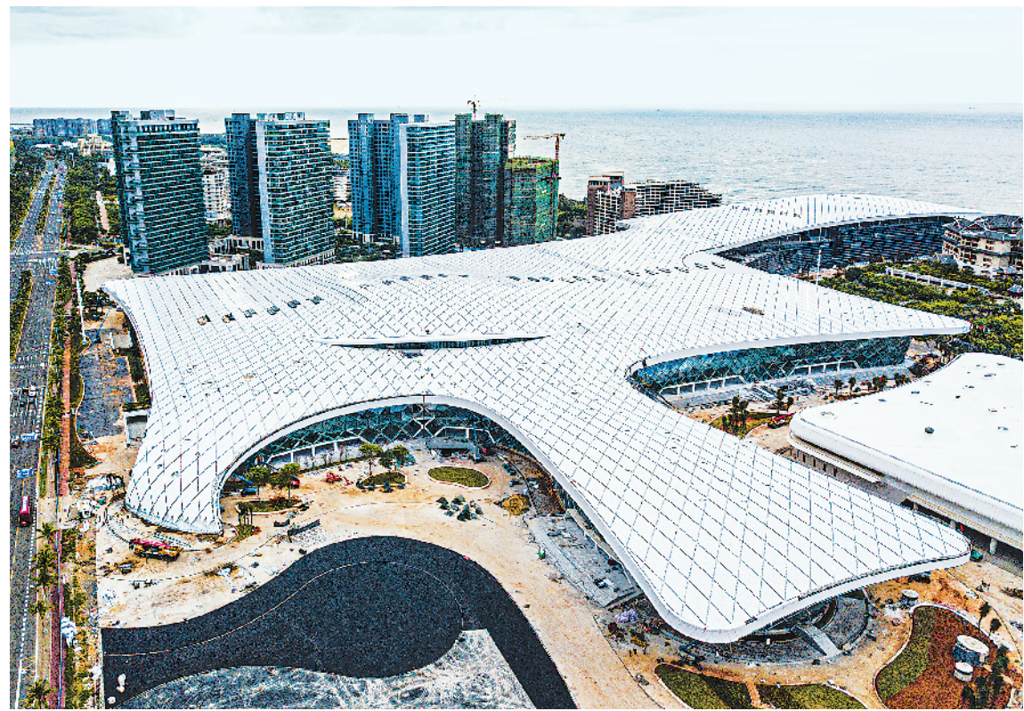
近期，位于海口的海南国际会展中心二期项目主体工程完工。目前项目正在进行收尾施工及系统运行调试。 新华社发
