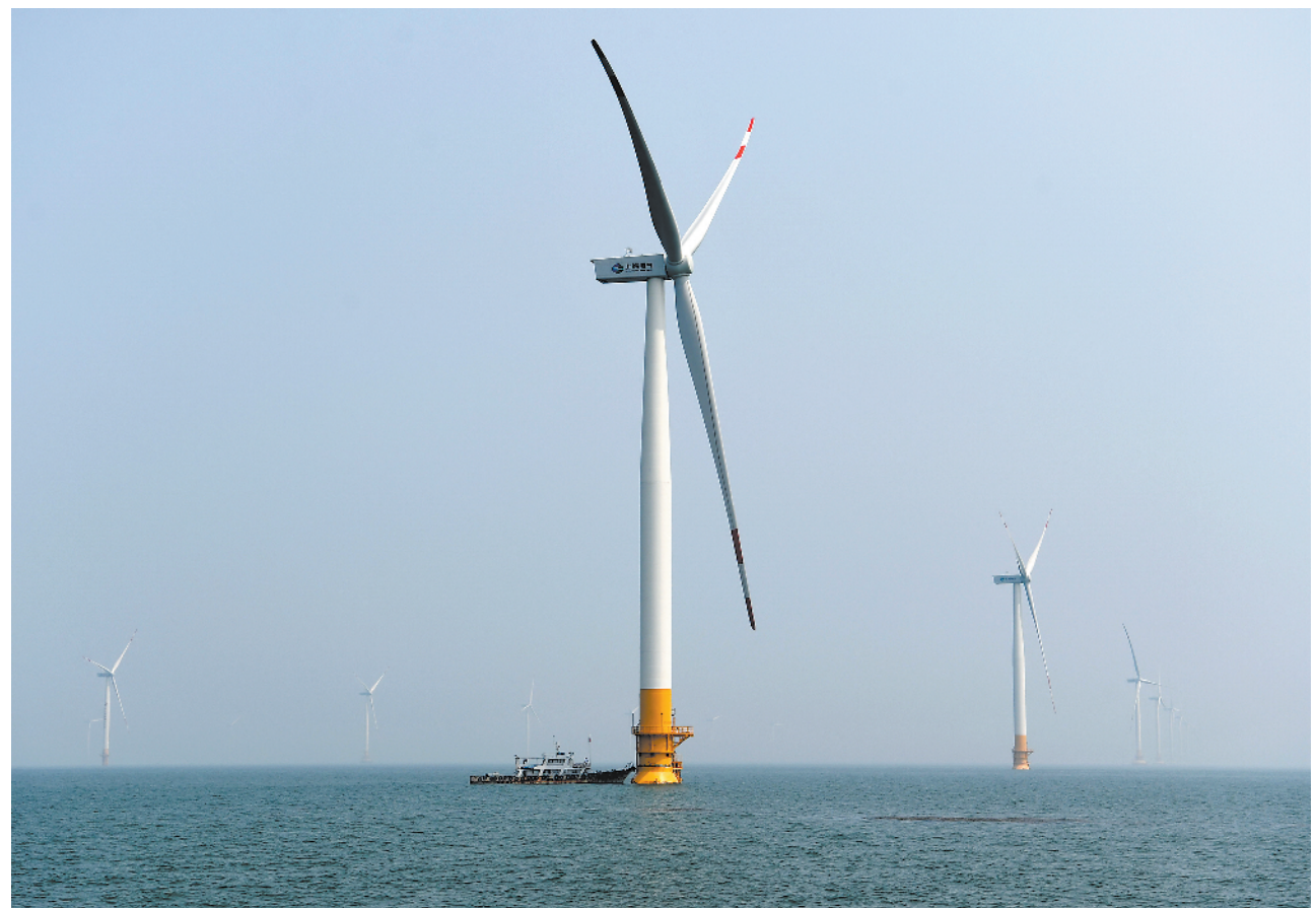
7月19日拍摄的唐山乐亭菩提岛海上风电场的风力发电机。近日,河北省首个海上风电项目——唐山乐亭菩提岛海上风电场全部风机并网发电。该项目装机总容量300兆瓦,共安装75台单机容量为4兆瓦的风电机组,预计年发电量7.6亿千瓦时。
