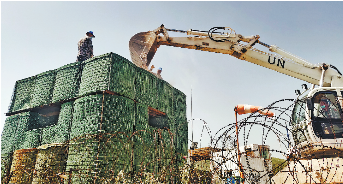
4月23日,中国第18批赴黎巴嫩维和建筑工兵分队圆满完成加纳维和营区观察哨新建任务,增强了安全防护能力。图为维和官兵为观察哨石笼墙装填砂石。
