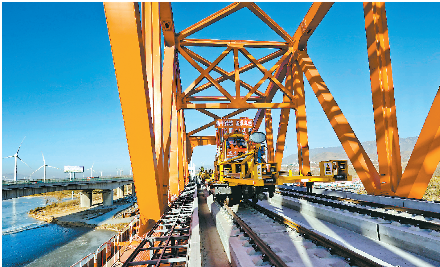
1月13日,京张高铁官厅水库特大桥铺轨工作完成。京张高铁全长174公里,是2022年北京冬奥会的重要交通保障线。图为中铁三局的工人在京张高铁官厅水库特大桥进行铺轨作业。 新华社发
