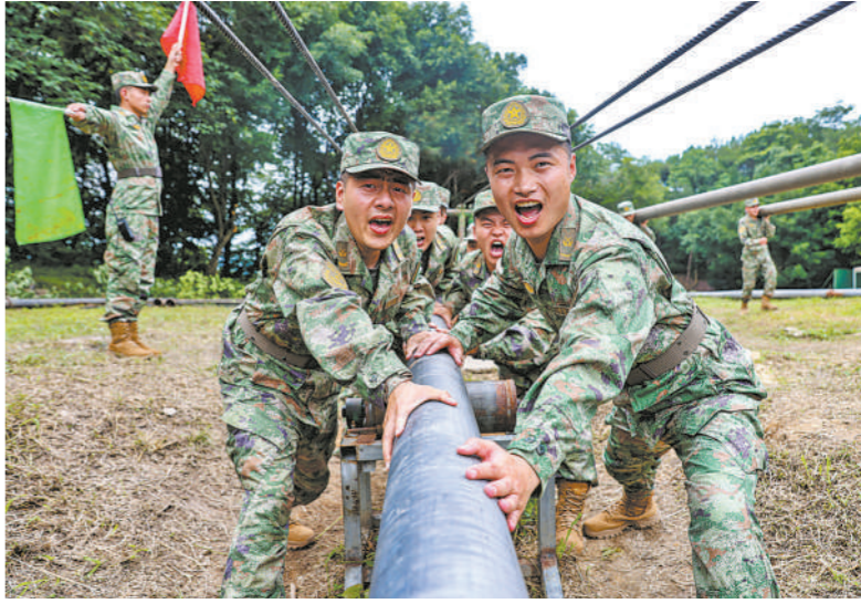
连日来，无锡联勤保障中心某团严密组织开展输油管线铺设及应急抢修训练。图为应急抢修推送钢管训练。张佳豪摄
