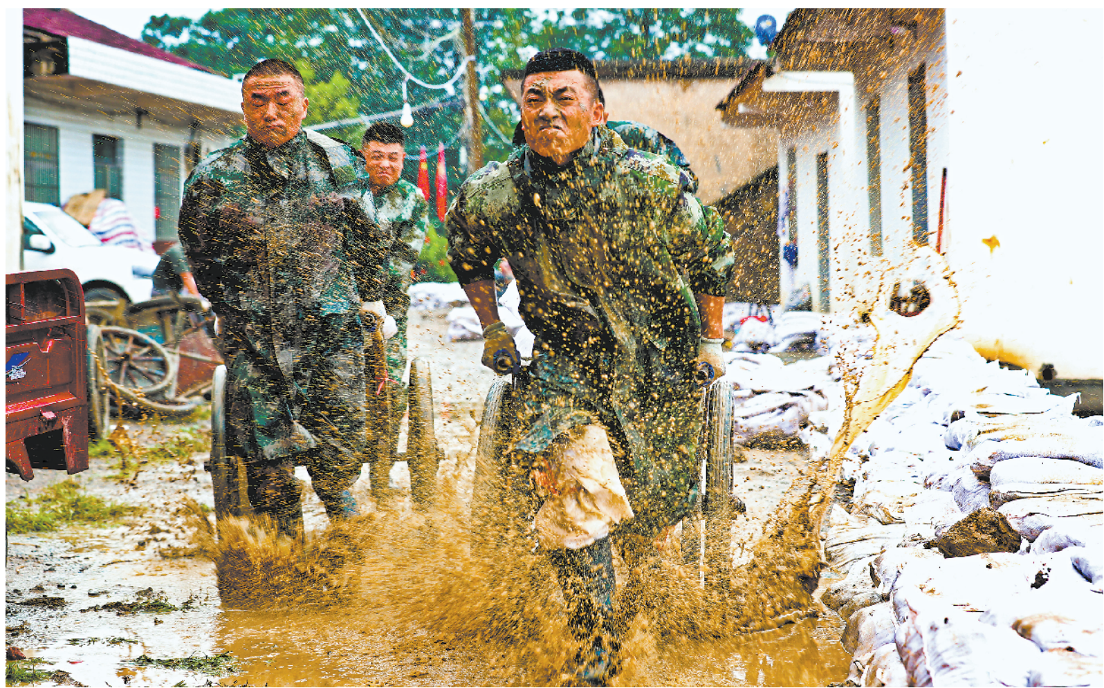
近日，陆军炮兵防空兵学院学员在巢湖白山水大桥段紧急加固堤坝，预防降雨带来的险情。李旭摄
