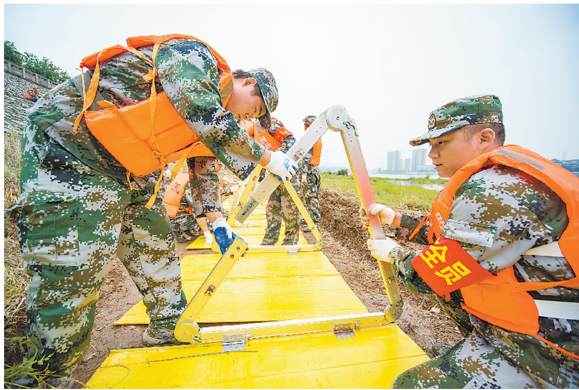
近日，湖南省常德市“澧水—二〇一九”民兵防汛抢险跨区机动演练在澧水流域举行。图为民兵应急演练分队使用新型折叠快装玻璃钢子堤，仅十分钟就修筑了四十米长的防洪子堤。 焦盛洋摄
